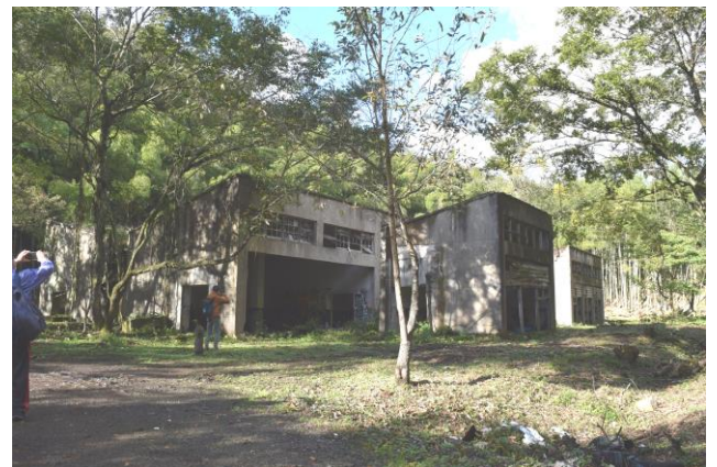
第3火薬廠跡内に残る砲弾製造工場の建屋
